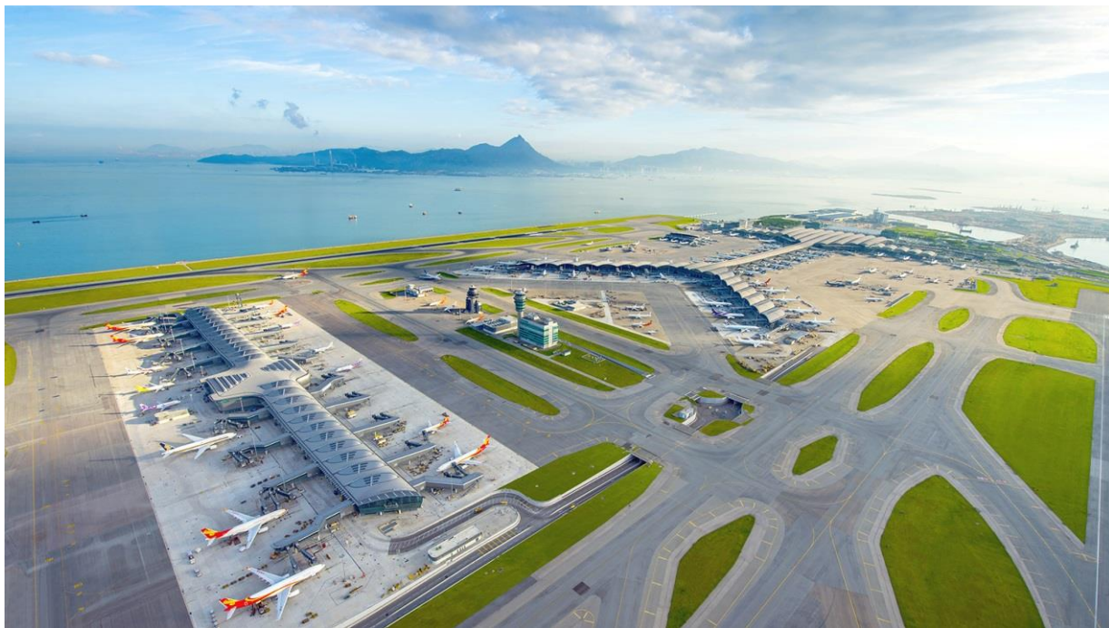
香港国际机场第三跑道
